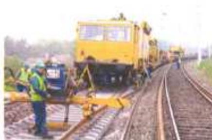
Longs Rails soudés sur traverses béton
